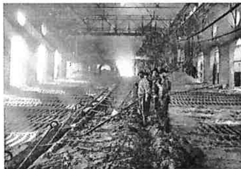
Figura 8: Vazamento de ferro-gusa, fundição Iroquois, Chicago, EUA, entre 1890 e 1901 10
